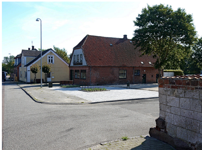
Anlægget af pladsen er påbegyndt her i efteråret
